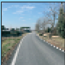
Asfaltature Via Brenta, Via Podgora, Via dell'Aviere, tratti di Via Pordelio
