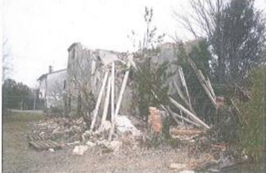
Vista interna (Sud-est)
